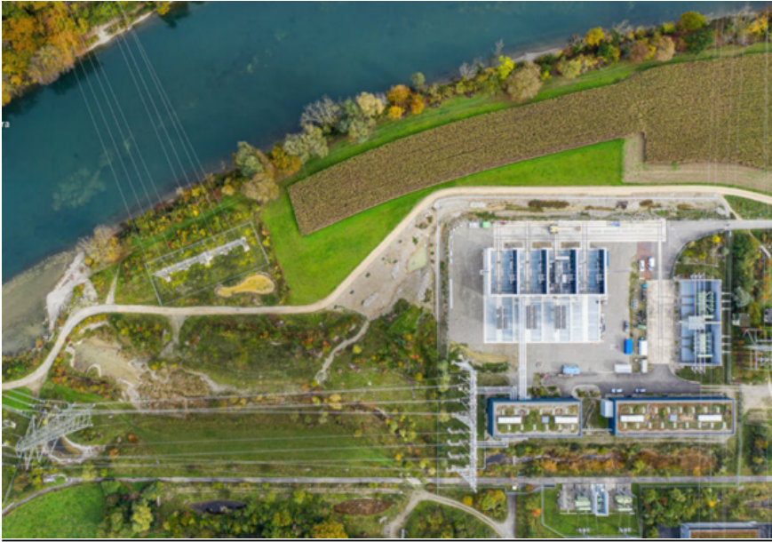
Swissgrid SA. Sinergie tra la costruzione di impianti e l'ambiente: la storia di successo della sottostazione di Mühleberg [24].
