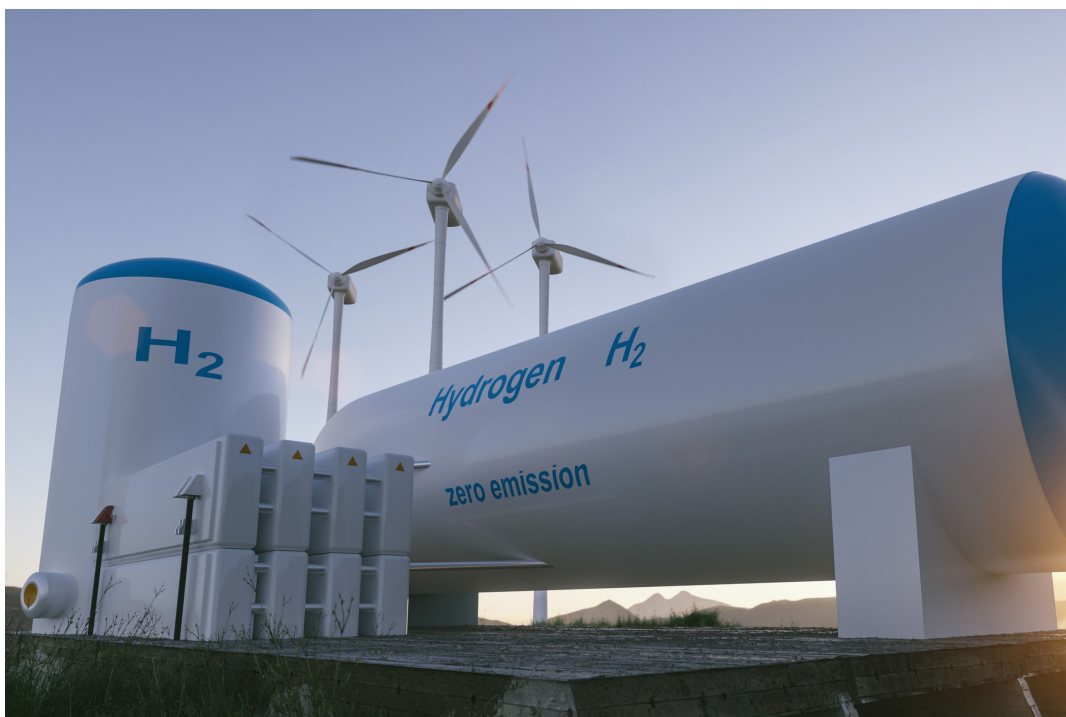
Sistema di stoccaggio dell'idrogeno per l'elettricità in eccesso proveniente dalle turbine eoliche. foto: audioundwerbung [16]
