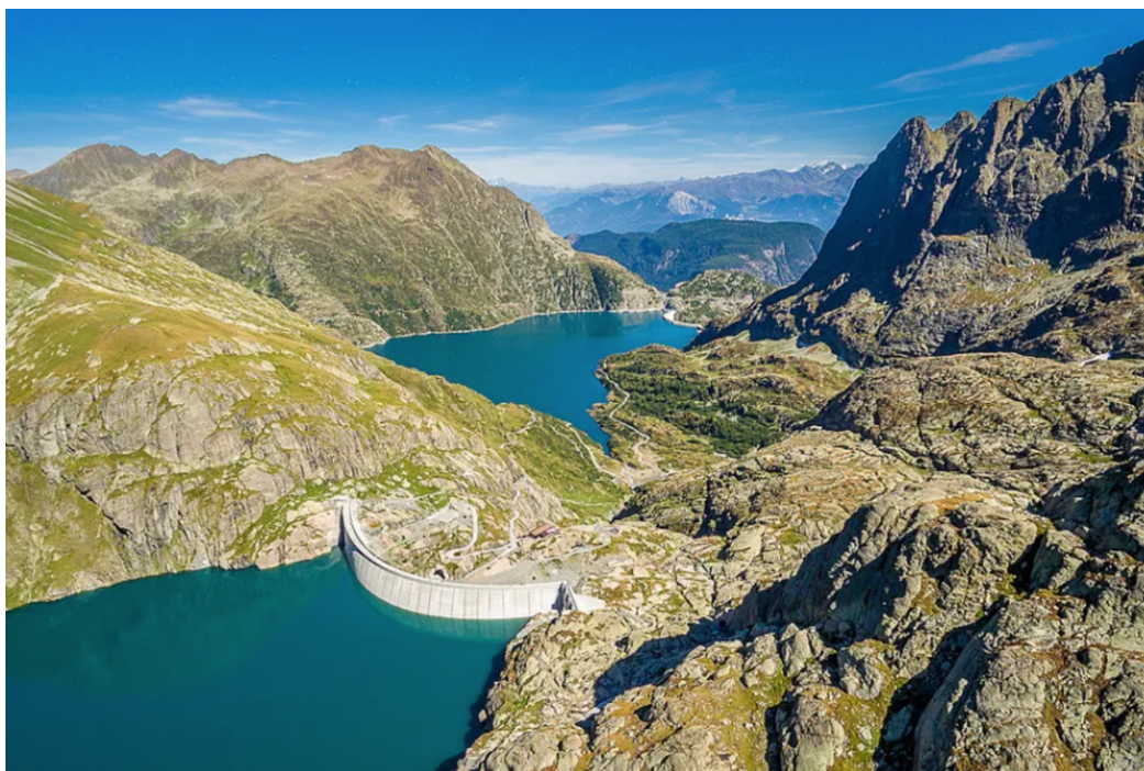
La centrale di Nant de Drance sfrutta due laghi artificiali: quello superiore di Vieux Emosson, in primo piano nell'immagine, e il lago inferiore di Emosson. Nant de Drance / Sébastien Moret [5]
