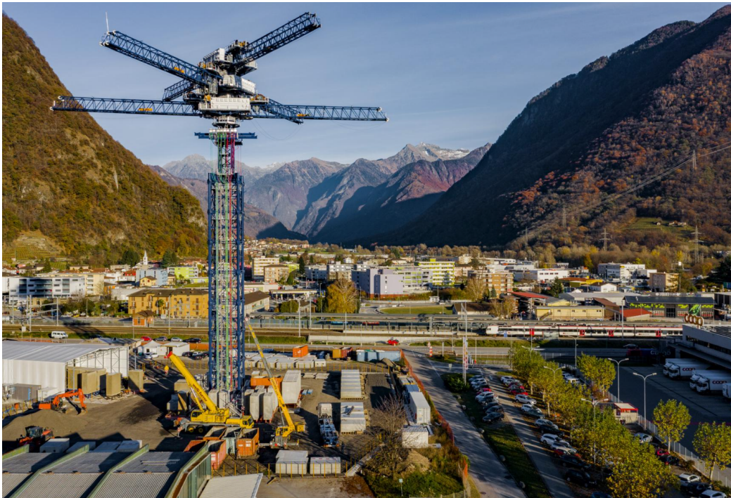
La torre dimostrativa installata a Castione collegata alla rete pubblica svizzera. Foto di Marcelo Villada Ortiz [7]
